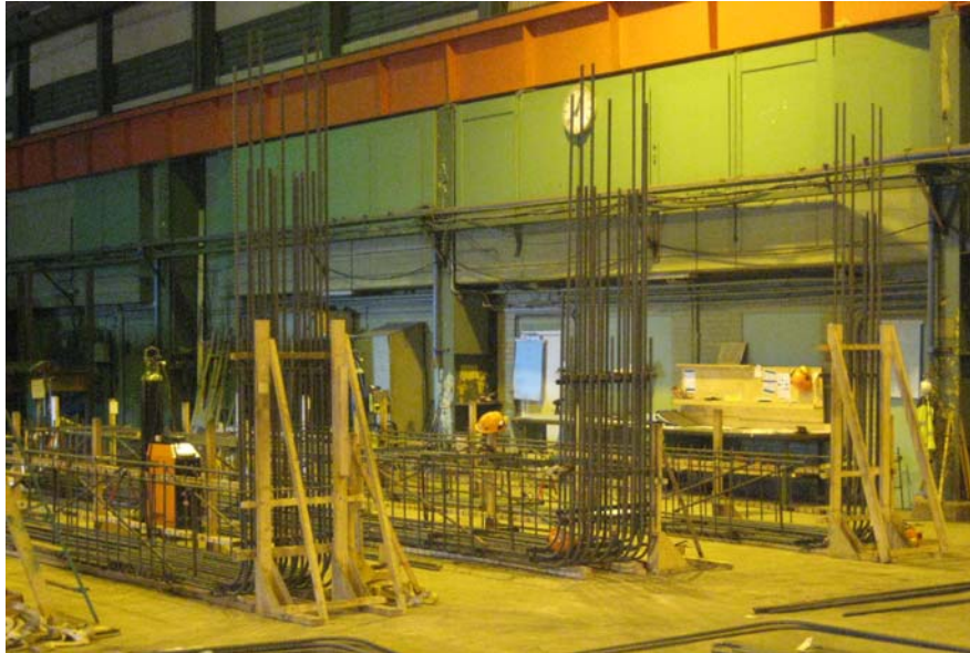
Figur 5.6 Förtillverkning i jigger på armeringsfabrik i Malmö. Montering sker här med najning och manuell svetsning.
