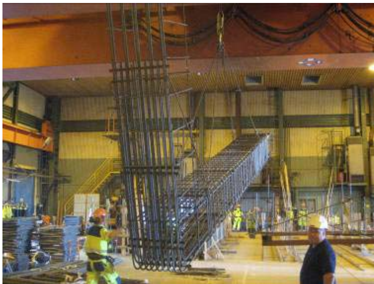
Figur 4.7 Förtillverkad armeringskorg lyfts ut ur fabrik för vidare transport.
