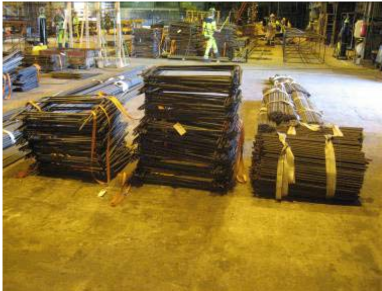
Figur 6.6 Upplag i monteringsfabriken för klippt och färdigbockad armering.
