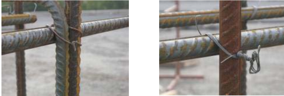
Figur 6.14 Vänster: Najning utförd manuellt. Höger: Najning utförd med najningsmaskin.
