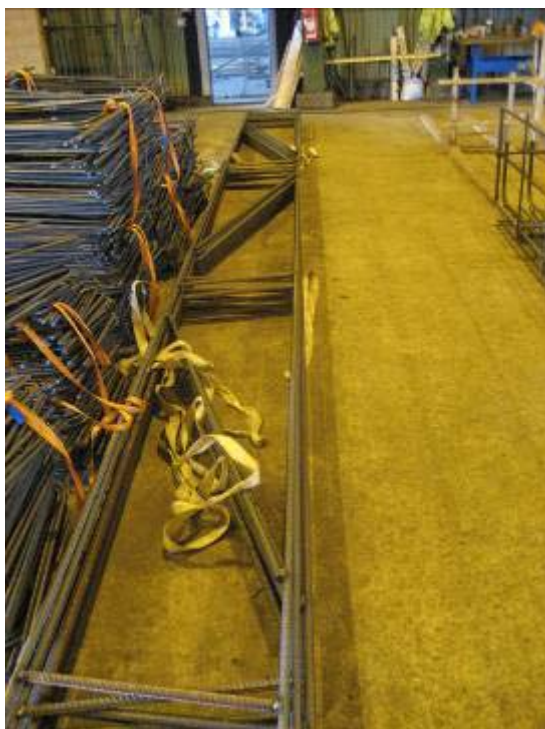
Figur 6.7 Svetsade monteringsenheter för stabilisering.
