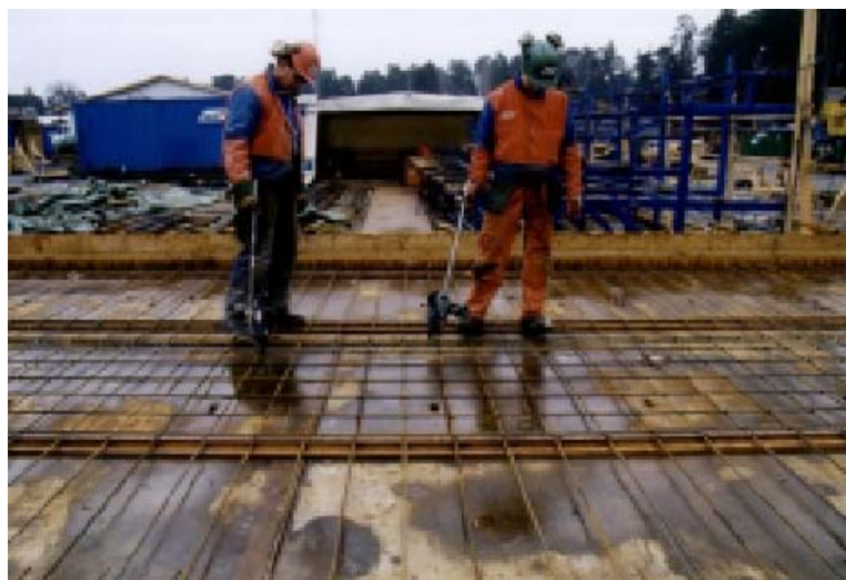
Figur 6.11 Montering av väggarmering med najningsmaskin i liggande jigg. Bild från NCC (2007).
