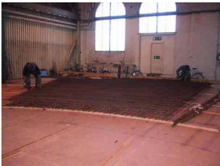
Figur 6.10 Förtillverkning av bjälklagsarmering i jigg. Foto: Tommy Wally.
