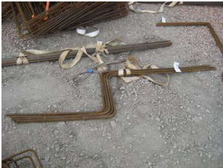
Figur 4.2 Buntad och märkt inläggningsfärdig armering, ILF.
